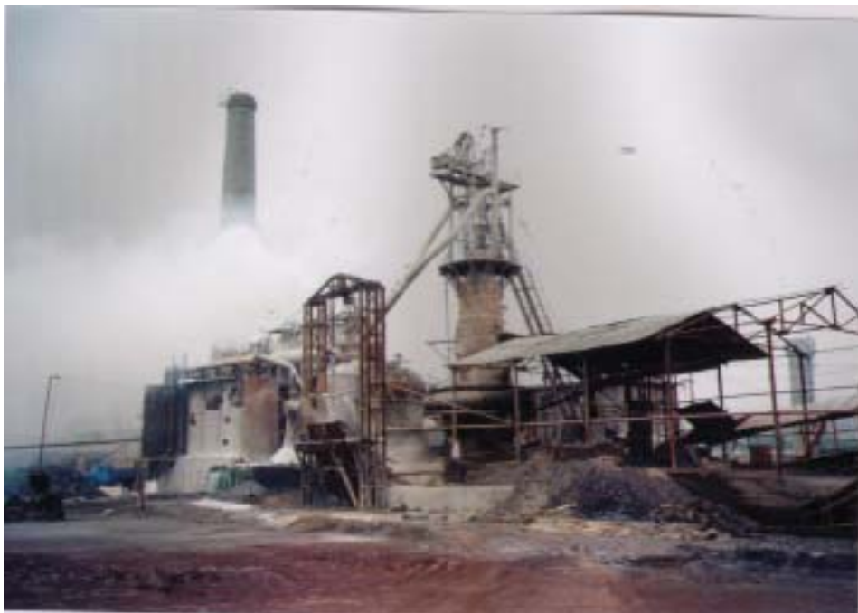
写真 20 改善されず白いダストを噴出す高炉
