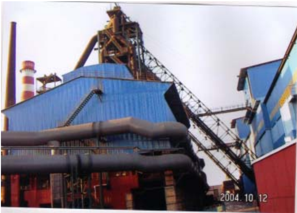
写真 14 2004年安泰高炉 (450M 3 第1高炉)
