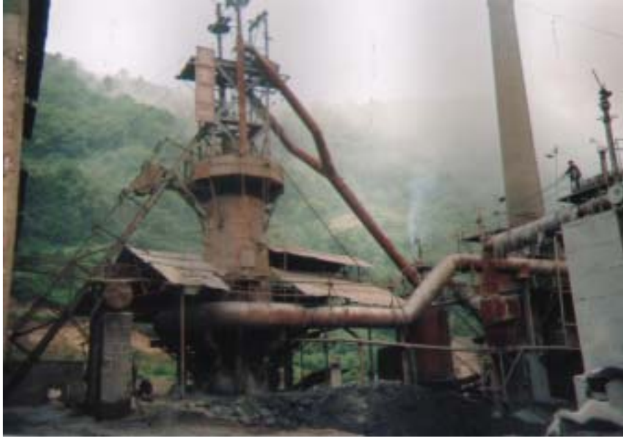
写真3 山西省の小型高炉(1) (内容積25M 3 :我が国の200分の1) ボロボロ高炉
