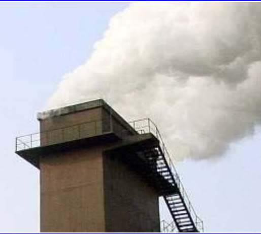
CWQ 湿式消火 散水
